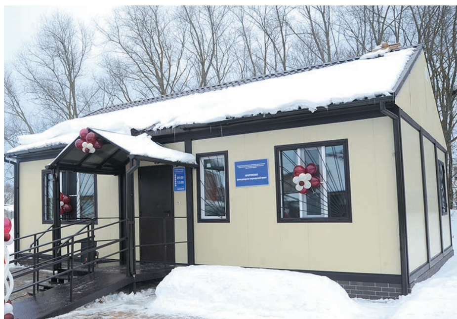
Модульный ФАП в селе Авчурино.
