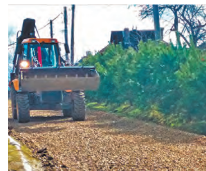
Грейдирование и подсыпка щебнем.
