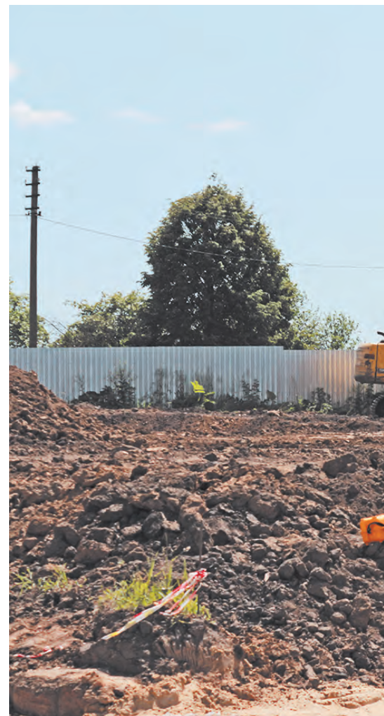
Стройплощадка станции водоочистки в Козельске.
