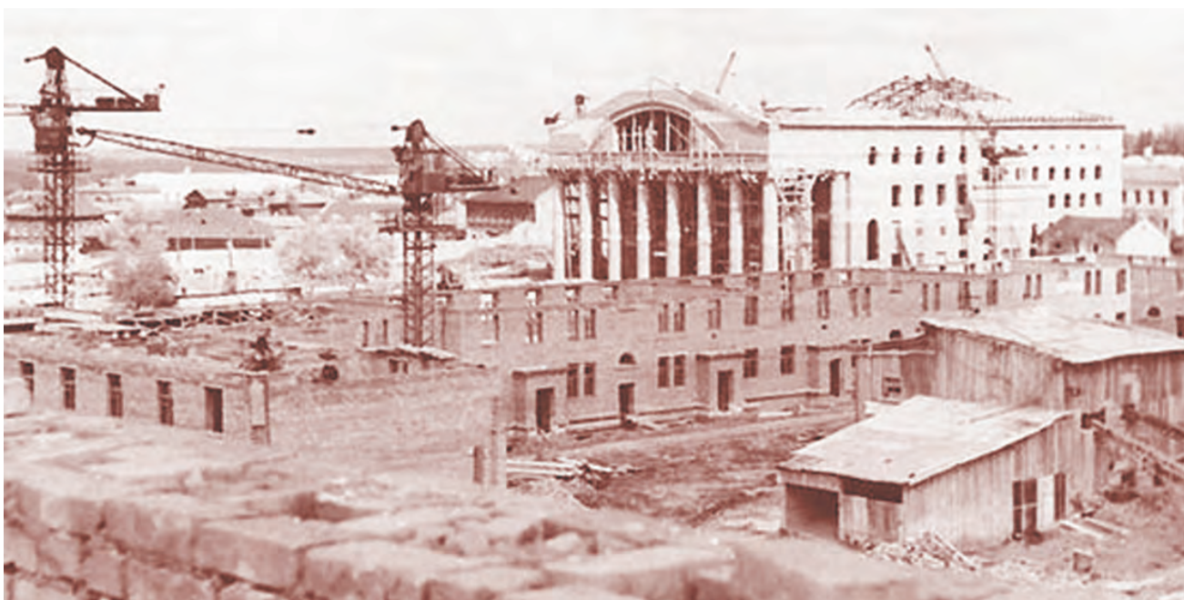
Театр строится. 1950-е гг.
