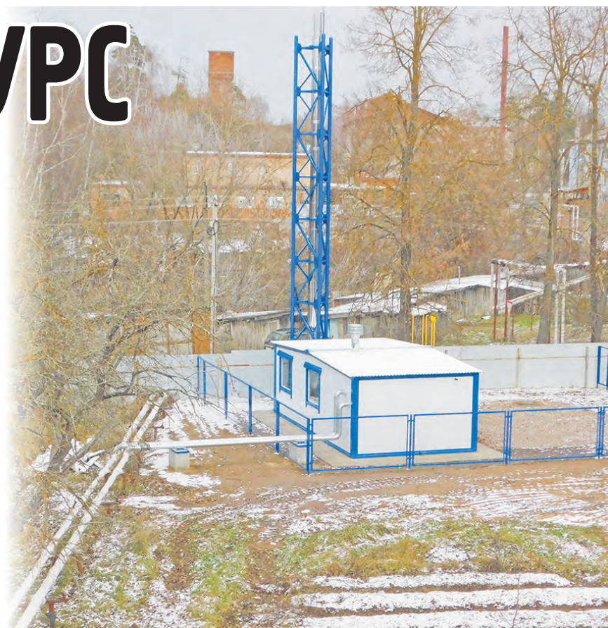
Скоро Полотняно-Заводскую школу №2 будет отапливать новая газовая котельная.
