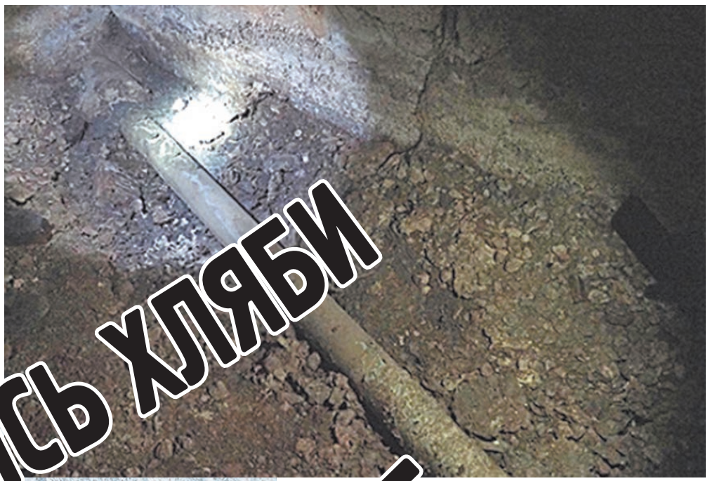
Прорванные канализационные трубы в подвале в Товаркове.
