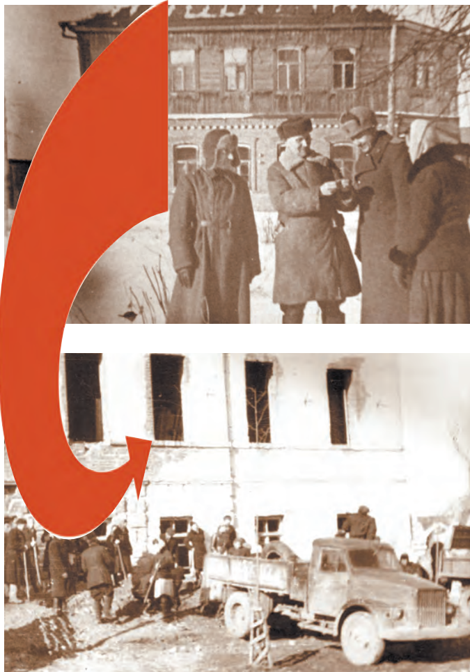
Разбор завалов разрушенного здания райисполкома в Мещовске.
