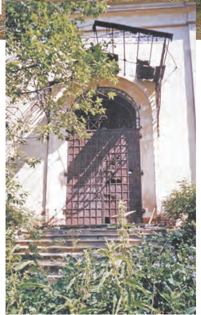
Нижняя церковь села Боболи. Вход и козырек крыльца.
