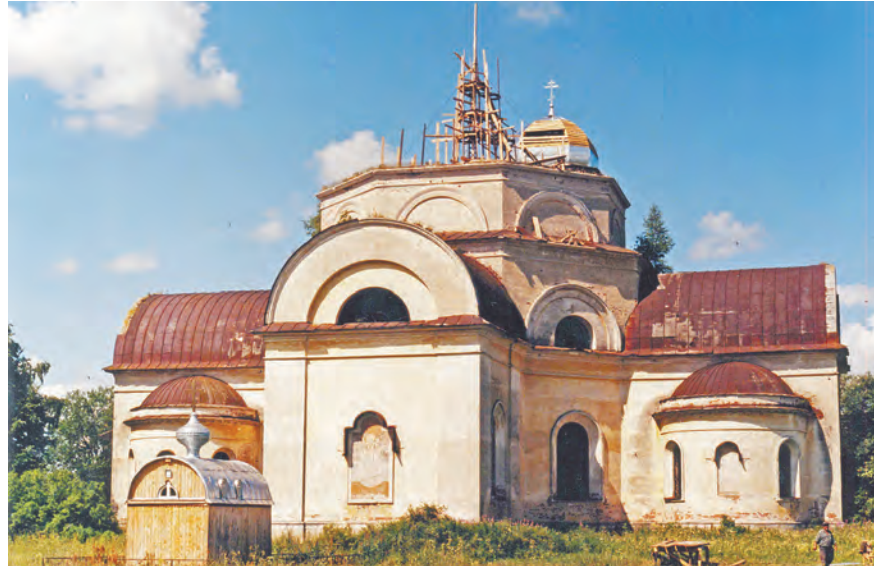
Никольская церковь села Боболя. Общий вид со стороны алтаря.
