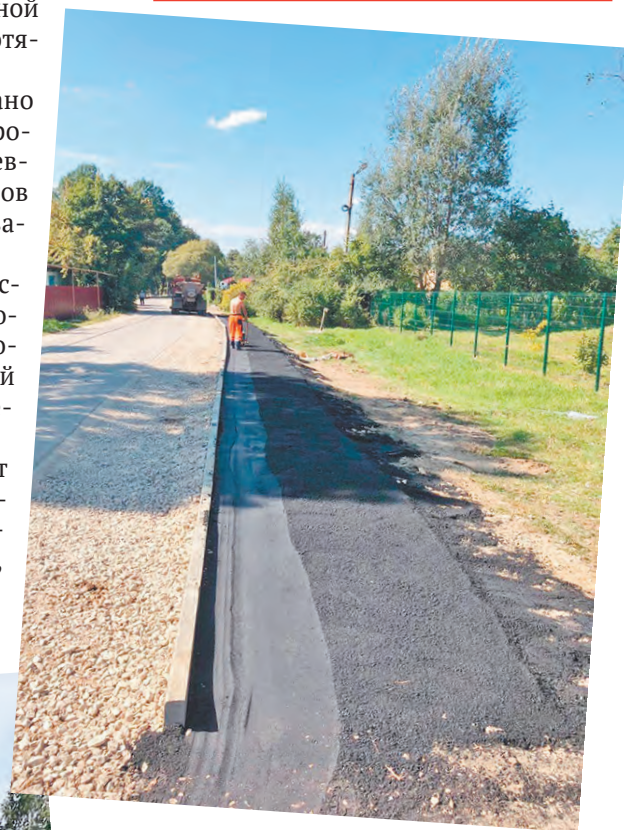
Строительство пешеходной дорожки в Авчурине.
