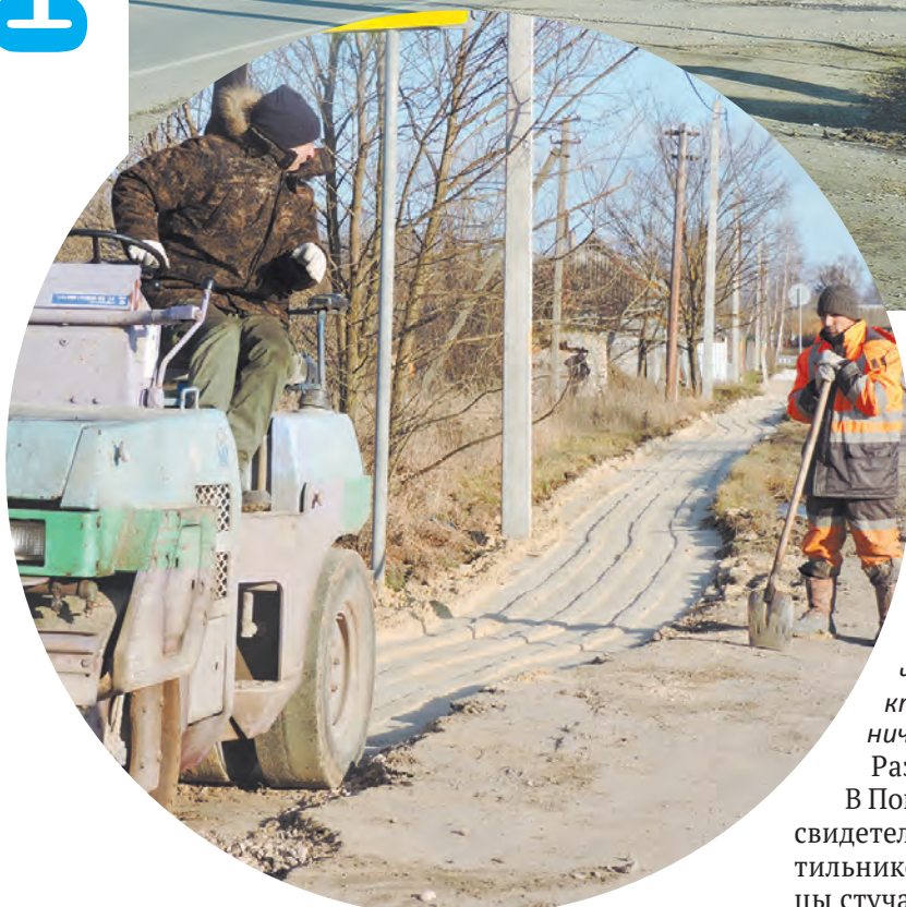
Строительство тротуара в Покровском.
