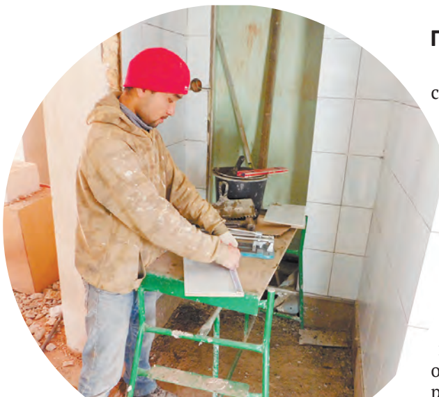
В бане идут отделочные работы.
