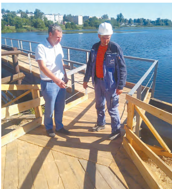
Временный понтонный мост для пешеходов.
