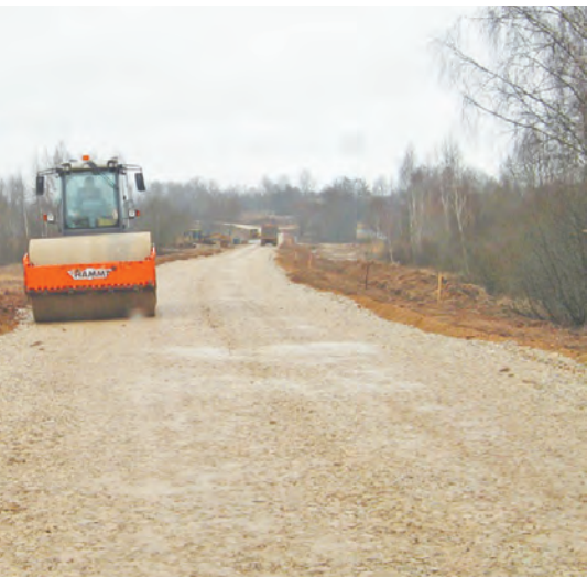
Ремонт дороги Раево - Губино.
