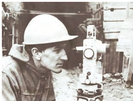
Тоннель Нагорный, 1977 год.
