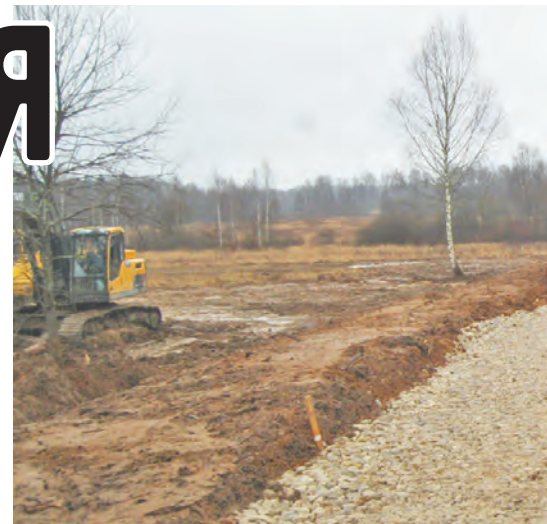
Уже идет ямочный ремонт улично-дорожной сети в райцентре.
