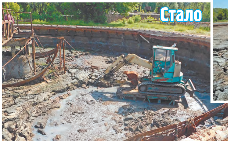
Идет очистка отстойника от многолетних залежей ила.
