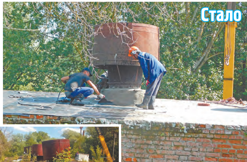
Ремонт кровли на воздухоподводящей станции.
