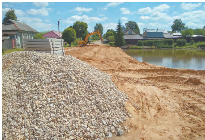
Пруд во время ремонта.
