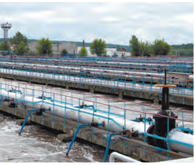
Очистные сооружения в областном центре.
