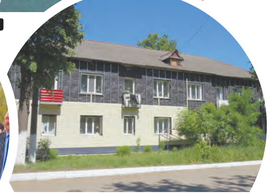
Капремонт фасадов домов.
