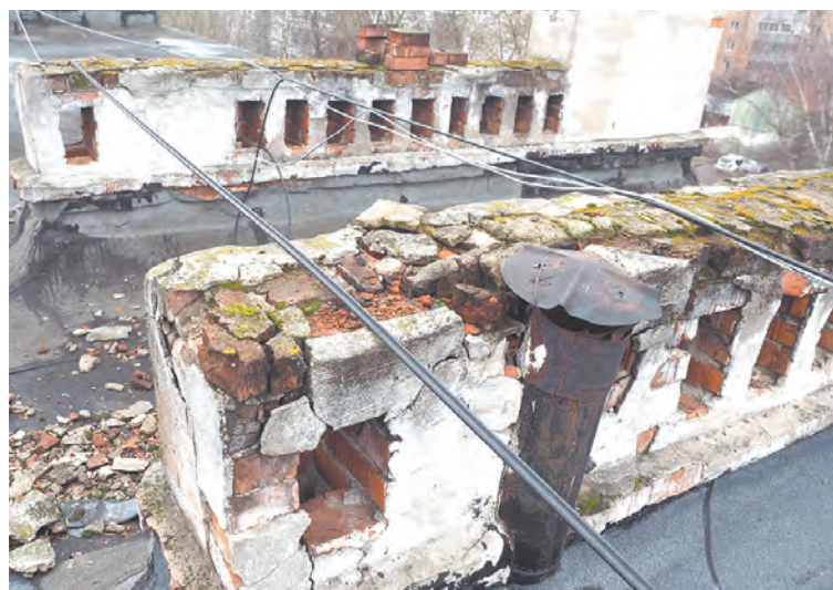
Дымоходы дома № 4 по ул. Поле Свободы.
