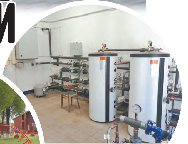
Новая котельная бани.
