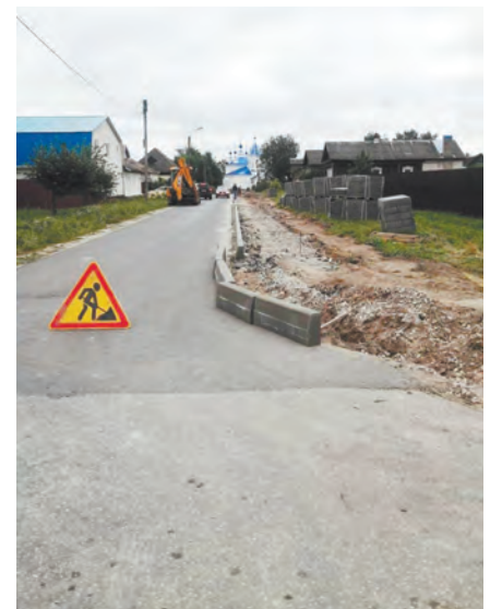
Строительство тротуара на Коммунистической.
