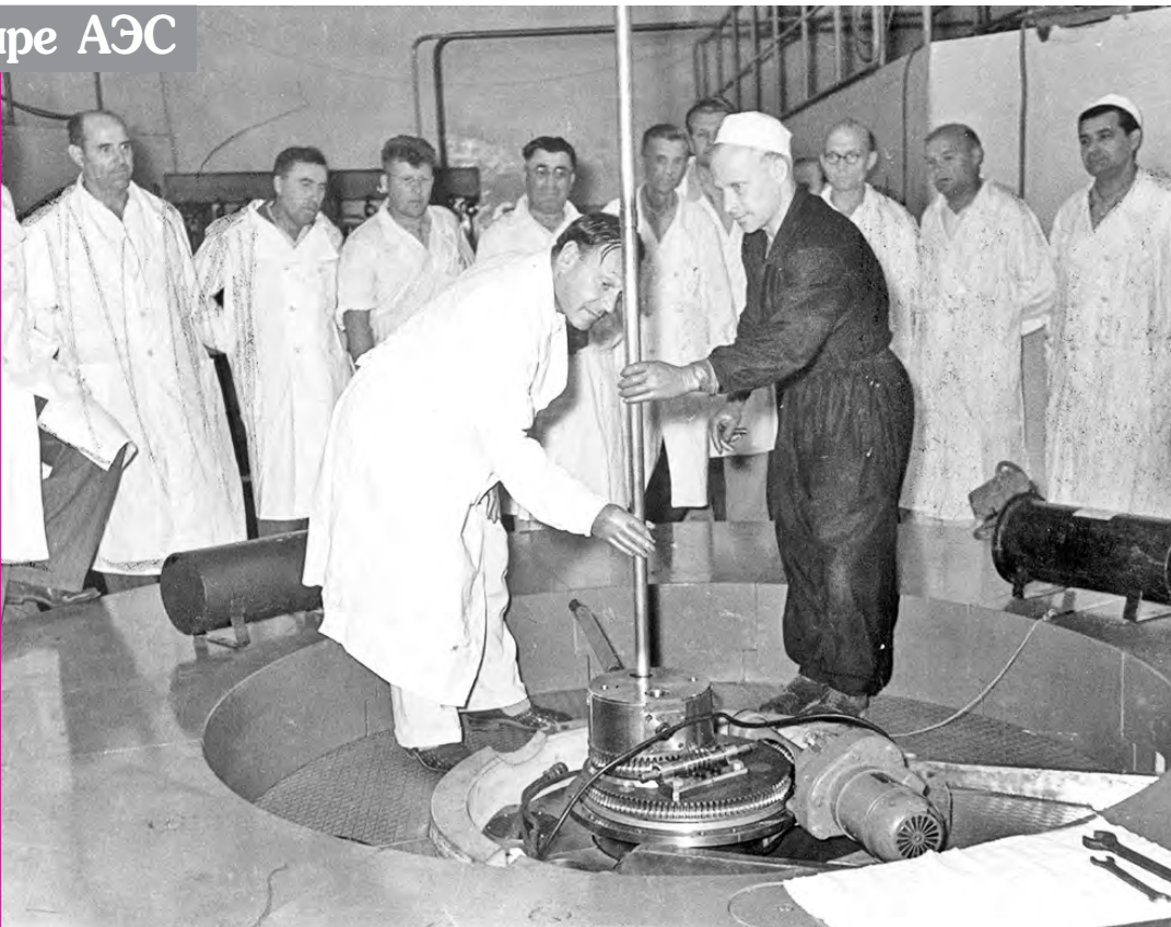
Научный руководитель секретной лаборатории «В» (позже ФЭИ) академик Александр Лейпунский (слева) и инженер Владимир Лебедев загружают топливную сборку в экспериментальный реактор БР-5. Он был построен и эксплуатировался обнинским ФЭИ с 1959 по 2002 год.
