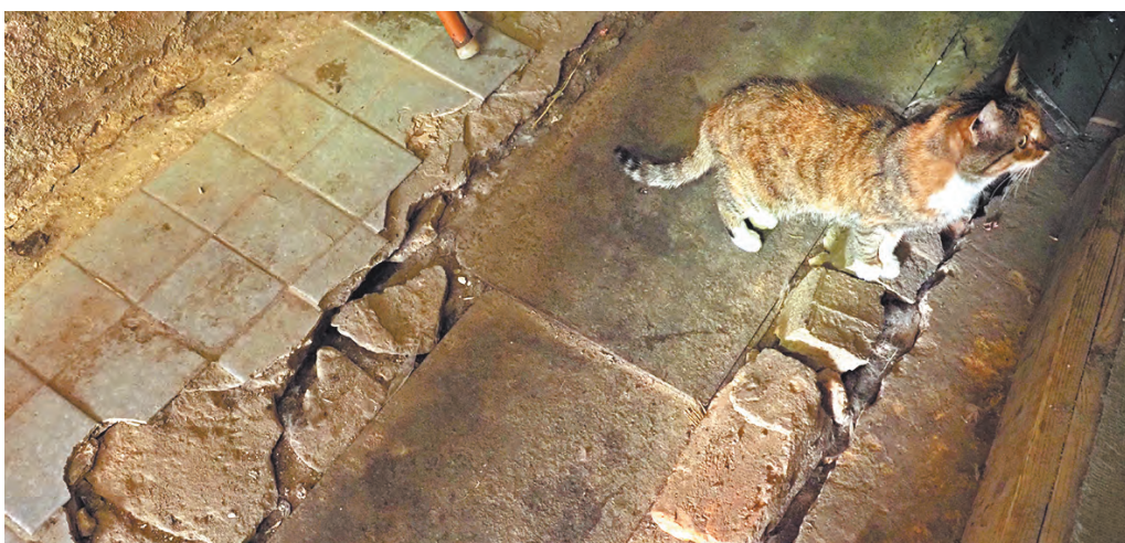
Внутри дома на Коммунистической, 18.
