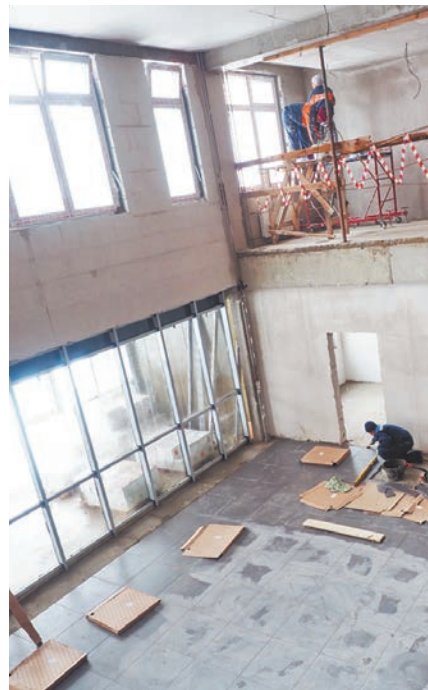
Школа в микрорайоне № 55 рассчитана на 1100 учеников и откроет свои двери 1 сентября. Сейчас здесь ведутся отделочные работы.
