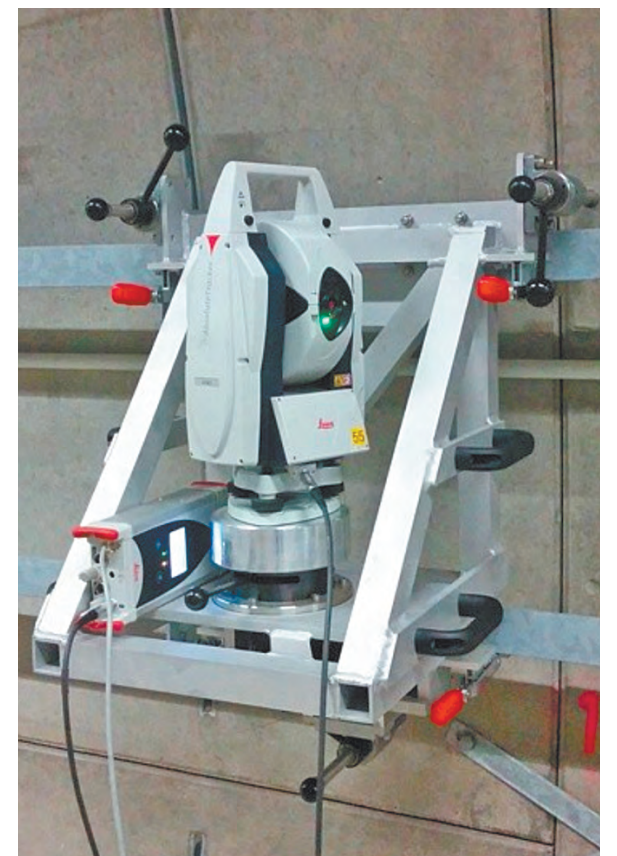
Лазерный контроль промышленного монтажа.
