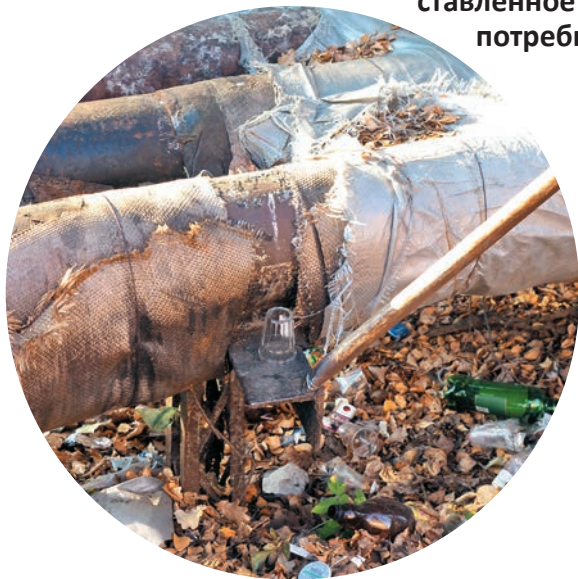
Оголённые трубы в Балабанове-1
