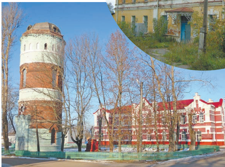
Водонапорная башня в Спас-Деменске.
