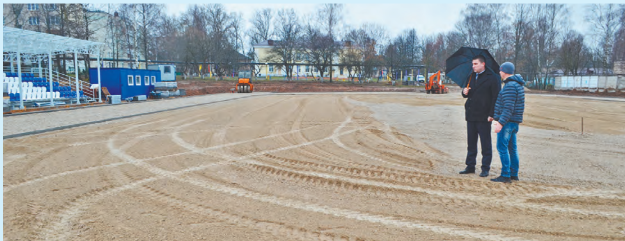
Вячеслав Парфёнов на стройплощадке.
